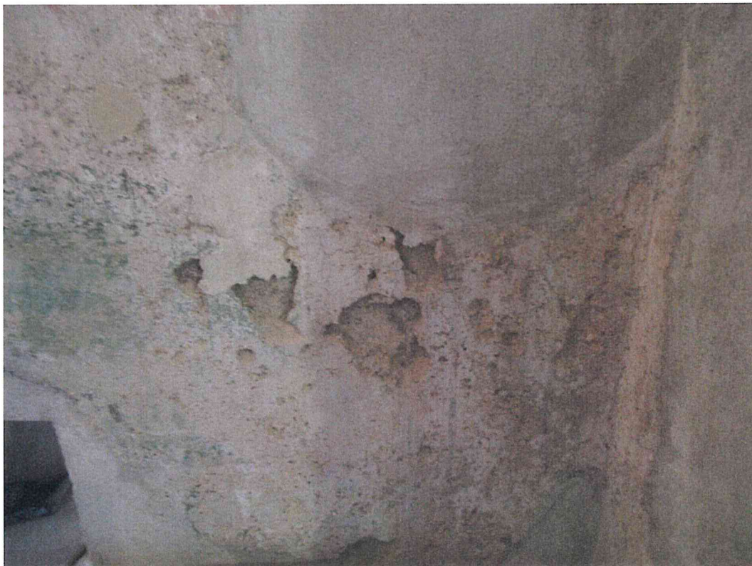
Disgregazione localizzata degli strati preparatori di supporto alla pellicola pittorica.
