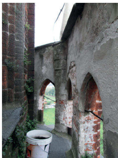
CAMPATA 1-2 - Mancanza di elementi laterizi (semicircolari); distacco e cadute di intonaco
