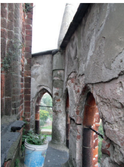
CAMPATA 3-4 - Al di sotto dell'intonaco ad impatto grigio, si intravede un intonaco con tinta rosa simile a quello ancora presente in tracce sugli sfondati delle archetti pensili
